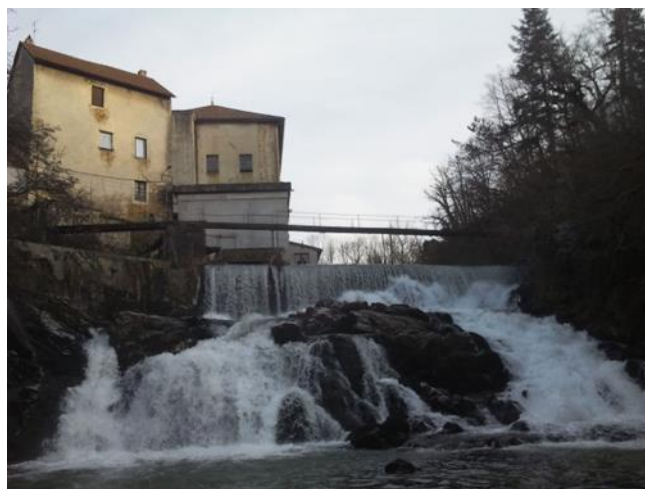
2 ème chute en aval de la papeterie
